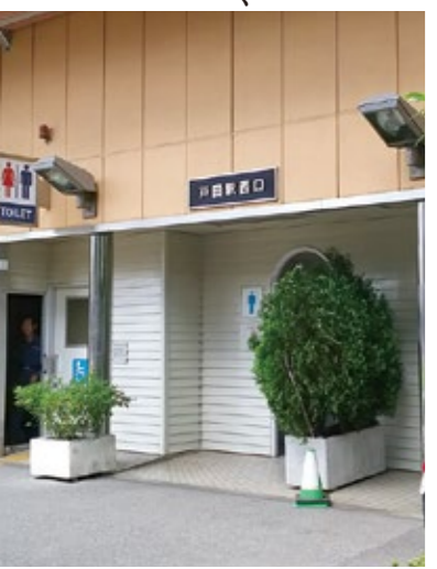
▲改修が予定されている戸田駅前公衆トイレ
